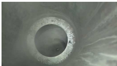
Open ondereinde rookgasafvoerkanaal
