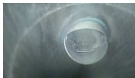
Licht verontreinigde aansluiting ketel
