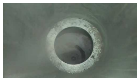
Open ondereinde rookgasafvoerkanaal
