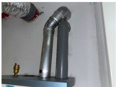
RGA/LTV aansluiting Norbruislaan 486
