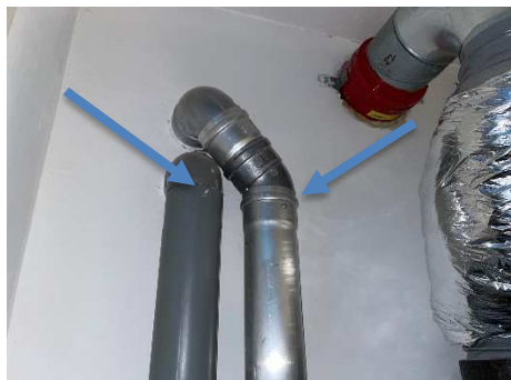
RGA/LTV aansluiting Gerhardstraat 7 incl. de Parker schroeven
