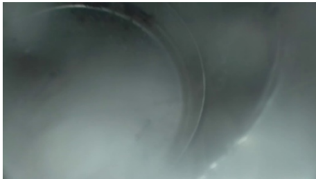
Binnenzijde inspectievoorziening CLV-kanaal
