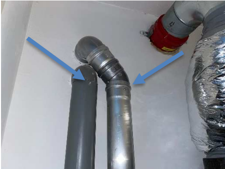
RGA/LTV aansluiting Gerhardstraat 7 incl. de Parker schroeven
