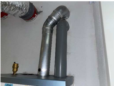
RGA/LTV aansluiting Norbruislaan 486
