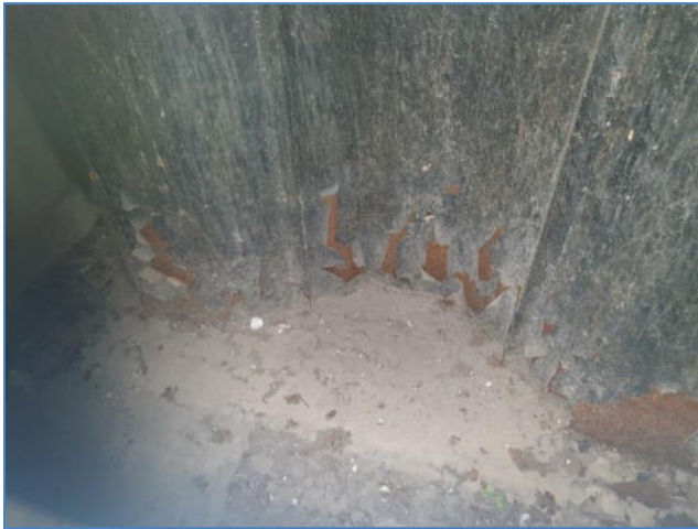
Put 2, detailopname bij vloer.
