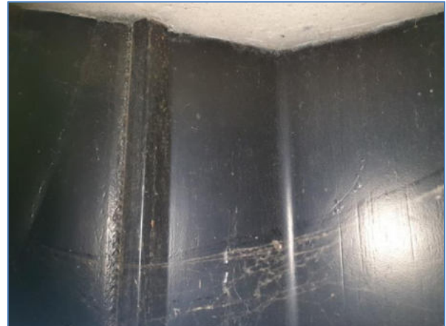
Zwarte coating met spuitbus aangebracht.
