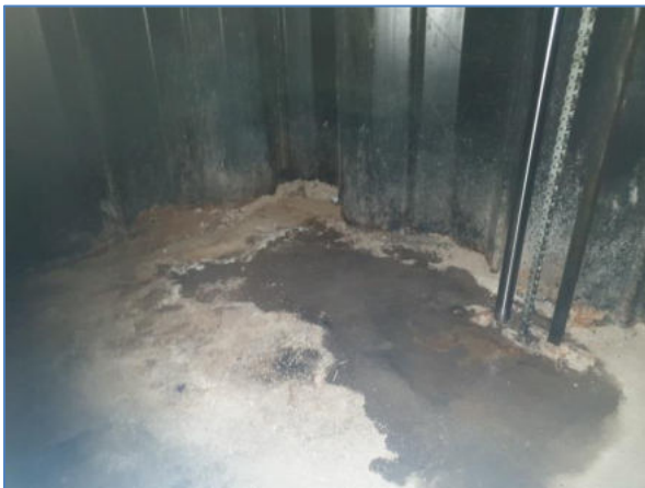
Put 1, oliekkage van auto. Kattenbakkorrels op de vloer gestrooid.
