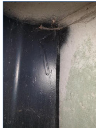
Put 2, detailopname, zwarte coating met spuitbus opgebracht. Duidelijk zichtbaar op de naastgelegen betonnen wand.
