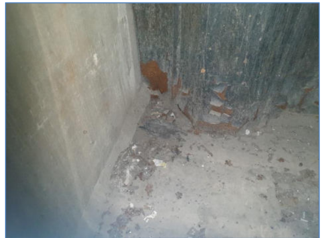
Put 2, detailopname in hoek bij overgang betonwand.
