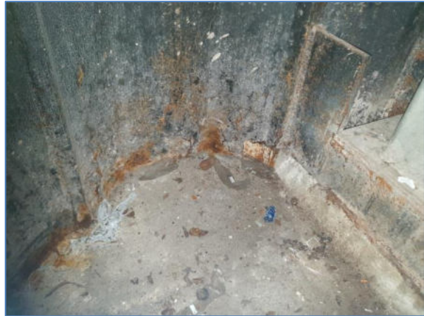
Put 1, tot 20 cm boven vloer roestvorming.
