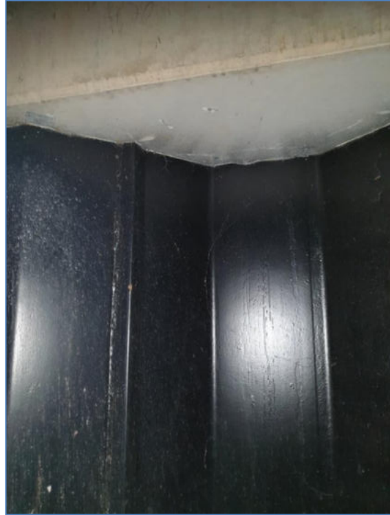
Zwarte coating met spuitbus aangebracht. Bovenzijde damwand.
