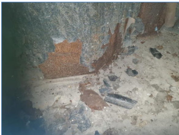
Put 2, damwand bij vloer.
