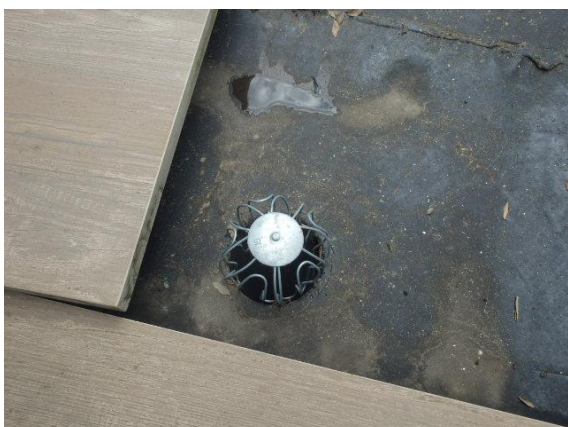
3: aanwezige hemelwaterafvoer
