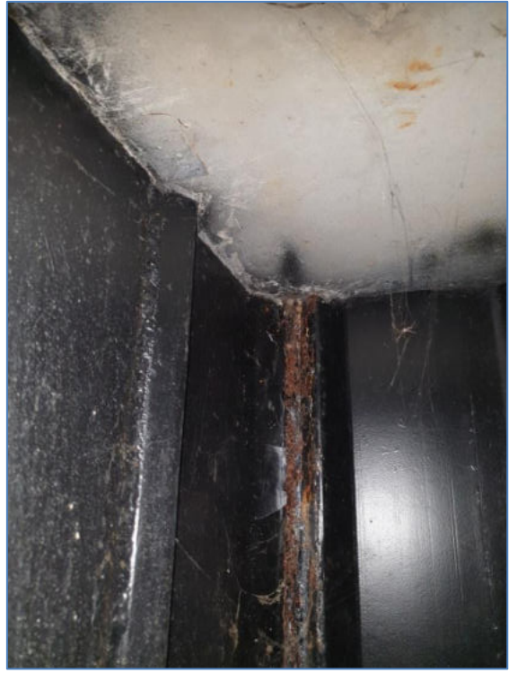
Zwarte coating met spuitbus aangebracht. Bovenzijde damwand.
