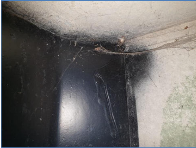
Put 2, detailopname, zwarte coating met spuitbus opgebracht. Duidelijk zichtbaar op de naastgelegen betonnen wand.
