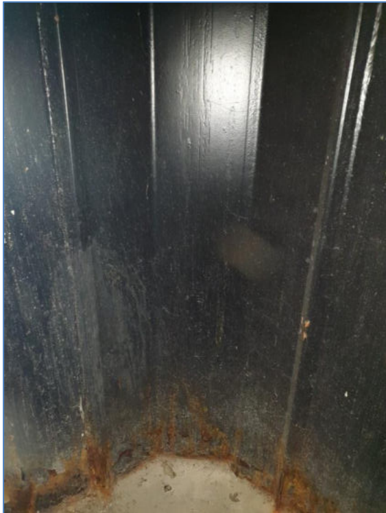
Zwarte coating met spuitbus aangebracht.
