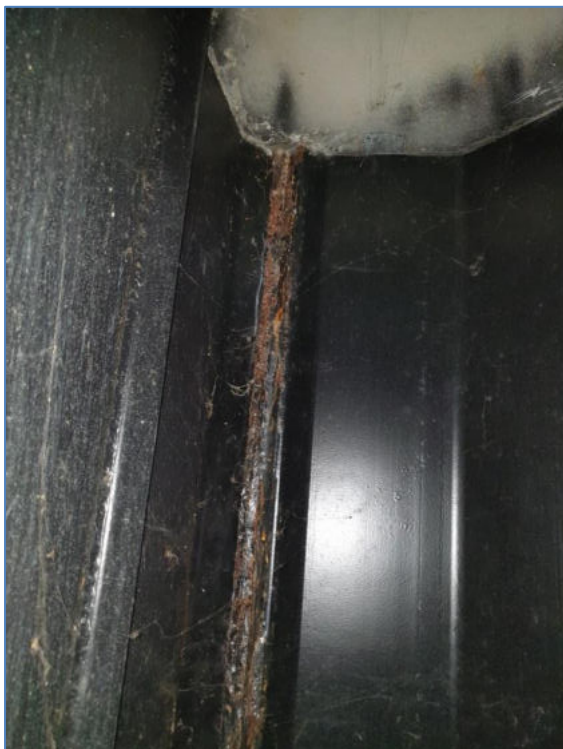
Zwarte coating met spuitbus aangebracht. Bovenzijde damwand.
