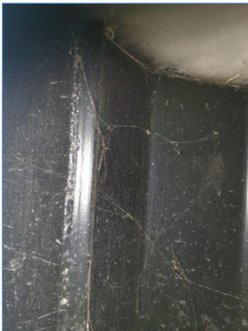
Put 2, damwand aan bovenzijde wand. Duidelijk zichtbaar een coating met spuitbus aangebracht.
