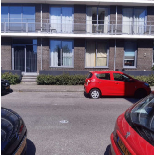
Geïnspecteerd tot onder wegdek Bavinkstraat.
